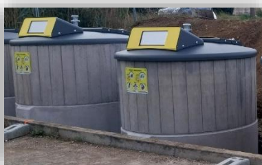
Colonne semi enterrée
