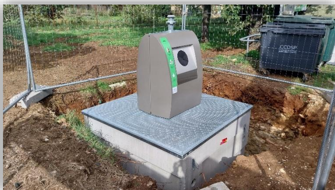
Travaux Suze la Rousse
