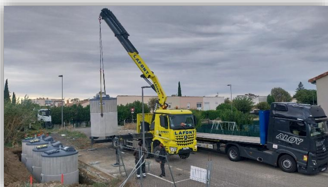
Travaux Donzère Point d'apport volontaire complet
